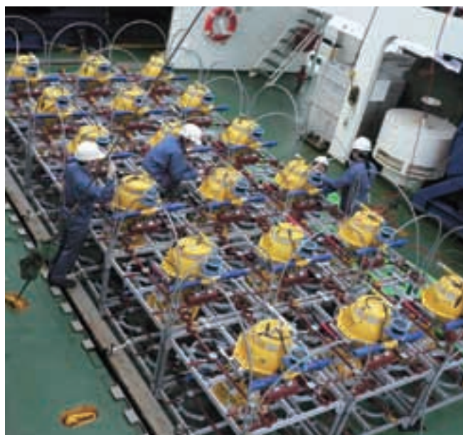
海底下の地殻構造探査のために、一航海で100台以上の海底地震計（OBS）を海底に設置します。
